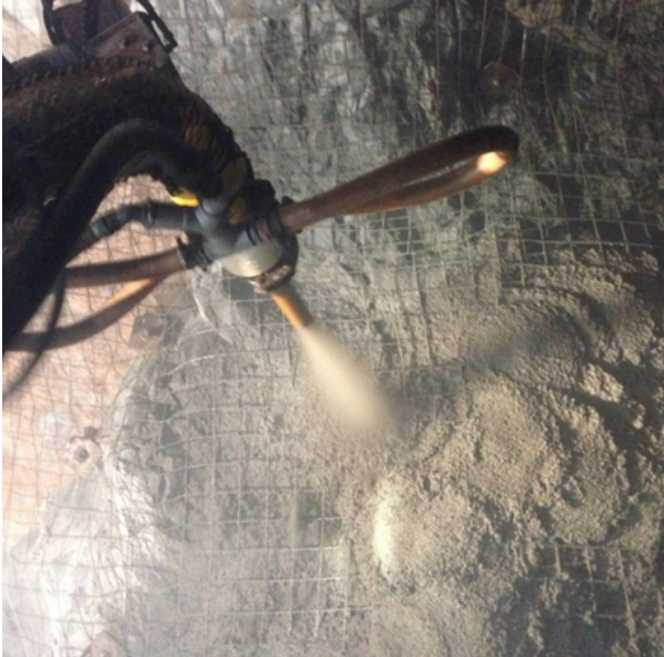
Figura 2. Adición del aditivo acelerante por la boquilla en la corriente de aire comprimido para salir proyectado a gran velocidad contra la superficie
