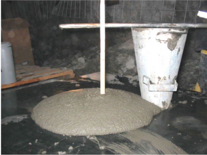
Figura 3. Prueba de revenimiento de un concreto lanzado
