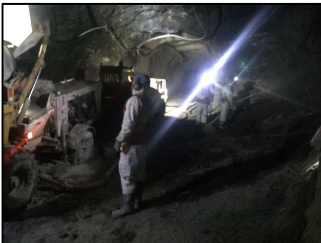
Fig.3 y 4: Aplicación manual del concreto lanzado vía húmeda.
