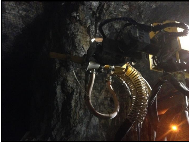
Fig.2: Aplicación robótica del concreto lanzado
