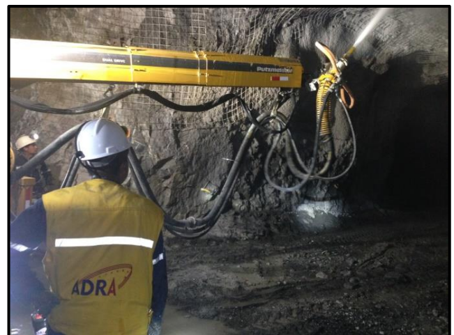
Fig. 1: Aplicación robótica del concreto lanzado
