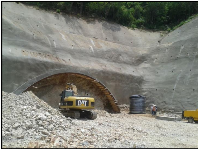
Fig. 6: Inicio de excavación de túnel una vez estabilizado los cortes del cerro con concreto lanzado.
