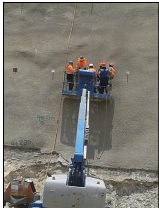
Fig.5: Estabilización de los portales con concreto lanzado de un túnel carretero.
