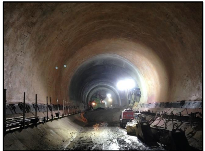
Fig. 7: Aplicación del concreto lanzado en túneles.
