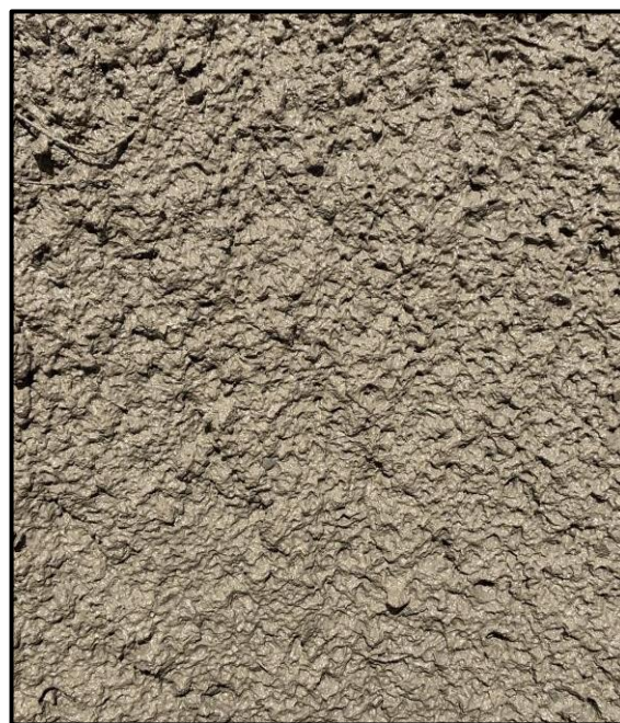
Fig.3: Concreto lanzado.
