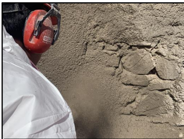
Fig.2: Facilidad en bombeo y lanzado.
