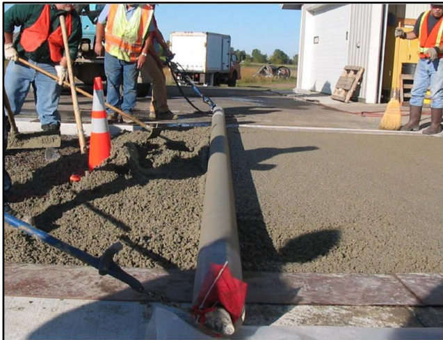
Fig. 3: Rodillo de compactación.
