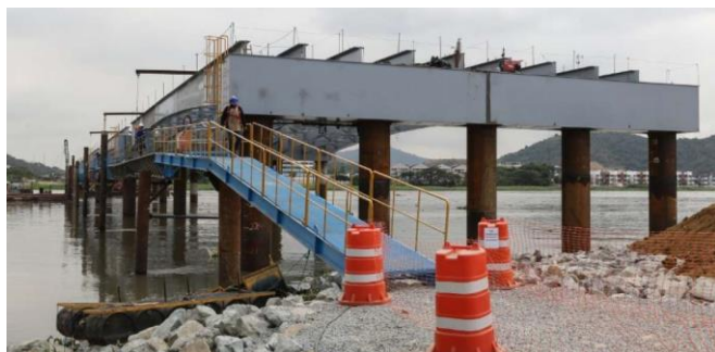
Fig.13: Puente Daule – Guayaquil, en construcción (Setiembre 2019).
