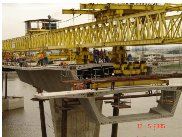
Fig. 5: Montaje de segmentos premoldeados.
