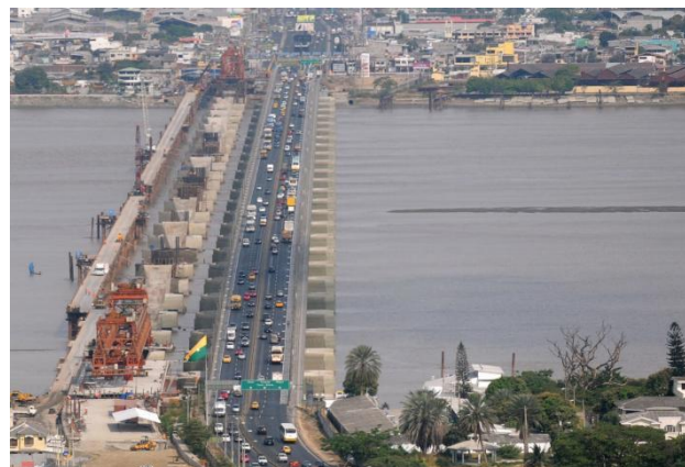
Fig.7: Nuevo puente sobre el río Babahoyo.
