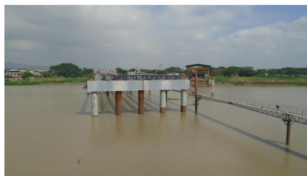
Fig. 9: Llenado de cabezales / vigas transversales.
