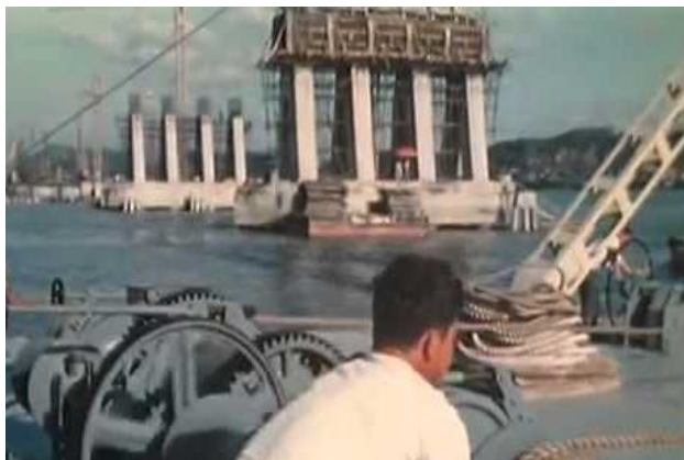
Fig.2: Puente sobre el río Babahoyo.
