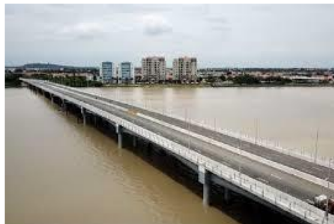
Fig.12: Puente Enlace 780 terminado (Junio 2018).
