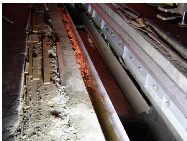
Fig.4: Concreto para Juntas.
