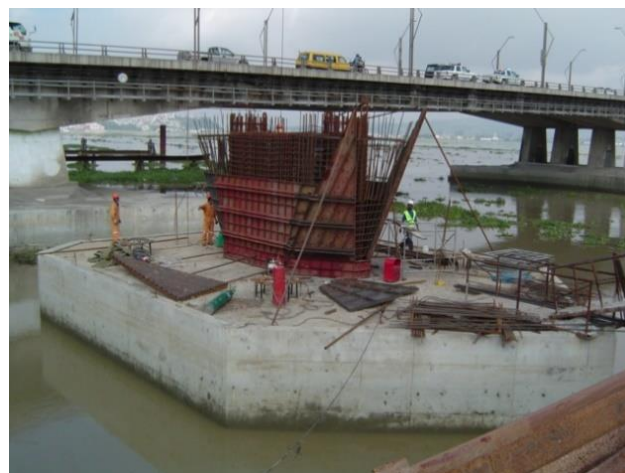
Fig. 6: Construcción de cabezal de pilotes y pila.
