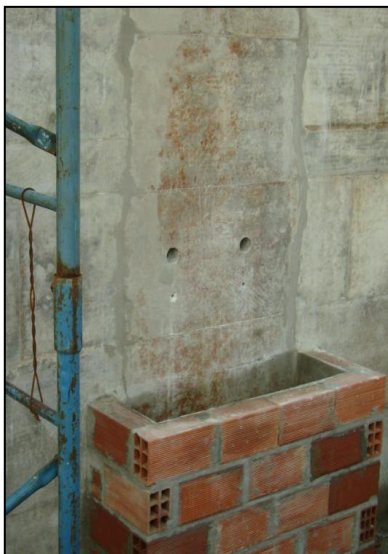
Fig.8: Cara donde se aplicó la carga hidráulica.
