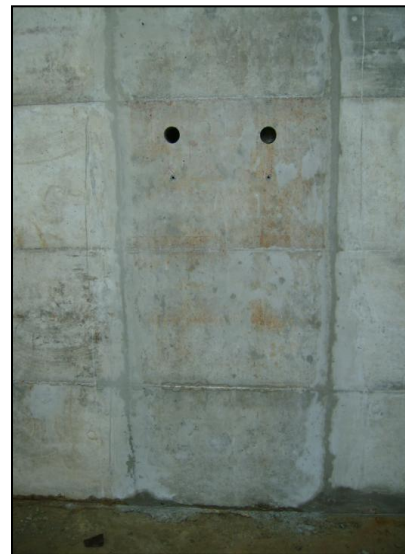
Fig.9: Cara posterior del tabique sin filtraciones.
